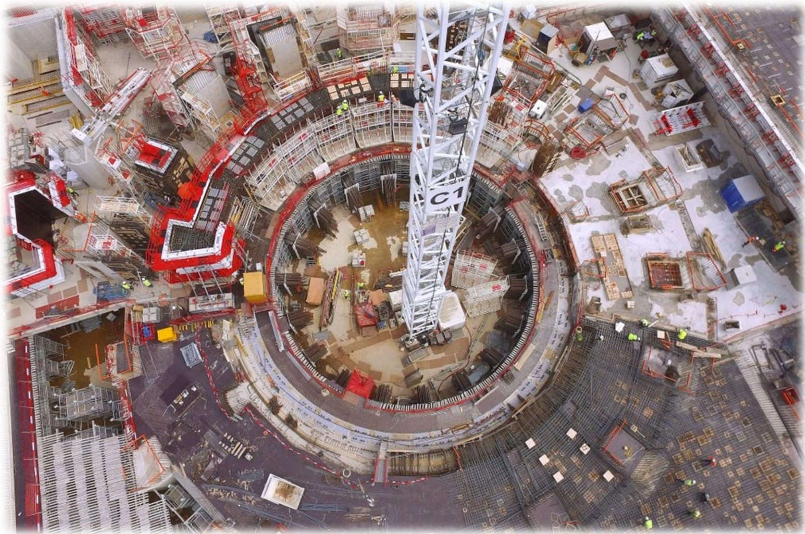
Строительная площадка ИТЭР в июле 2016 года
