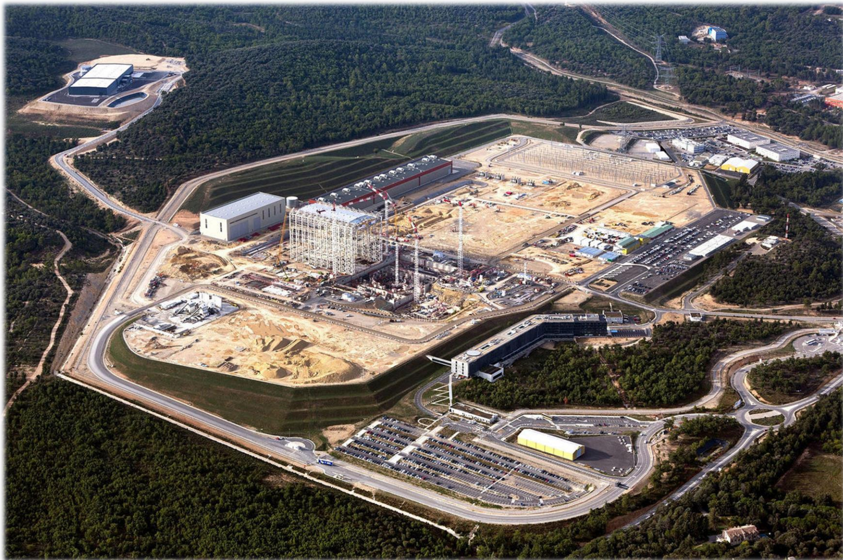
Строительная площадка ИТЭР в 2015 году
