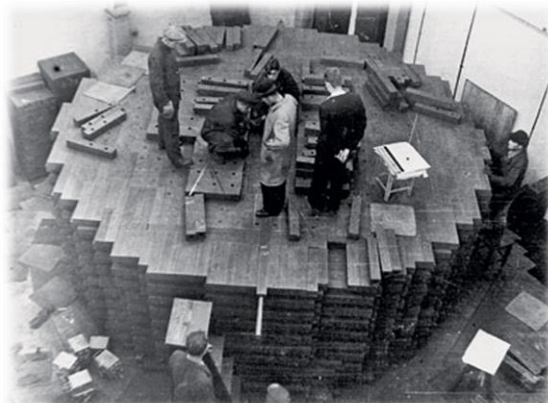
Первый реактор в Евразии Ф-1 запущен 25 декабря 1946 года в Лаборатории №2 АН СССР. Тепловая мощность 20 Вт.
